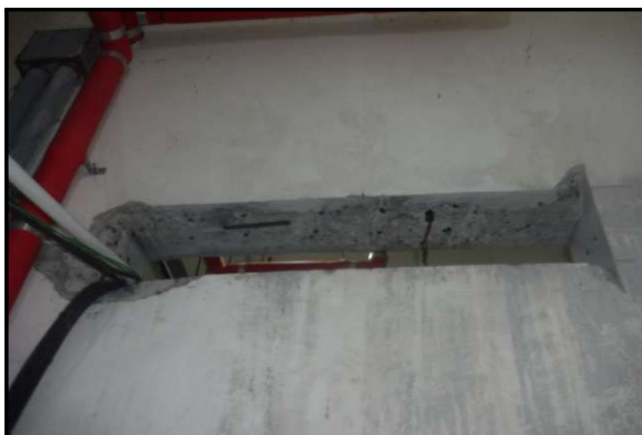
사진 17 지하1층 복도 벽체 현황번호 6 콘크리트 컷팅
