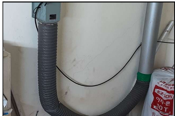
사진 12 지하1층 창고 벽체 현황번호 4 균열
