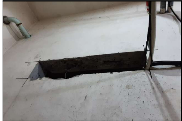
사진 14 지하1층 복도 벽체 현황번호 6 콘크리트 컷팅
